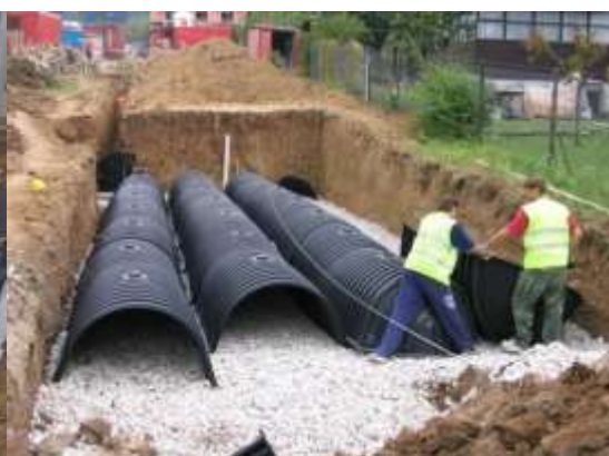
Instalace zasakovacích tunelů (zdroj: www.asio.cz )
