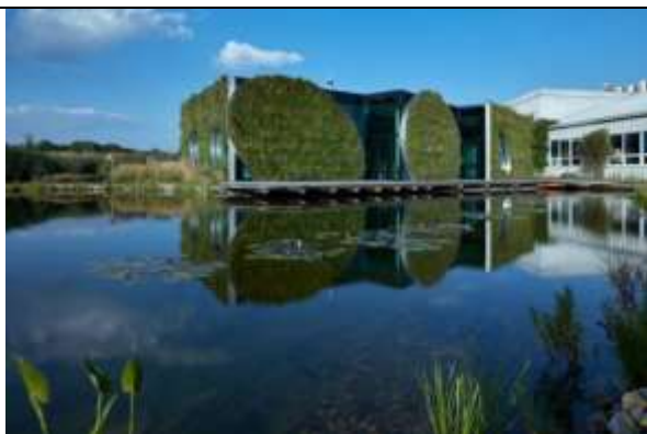
Zelená fasáda budovy vývojového centra společnosti Liko-S ve Slavkově u Brna pokrytá nerezovými kazetami s mokřadními rostlinami v porézním substrátu s bakteriemi pro čištění odpadních vod (zdroj: www.zelenafasada.cz , www.officesnapshots.com )
