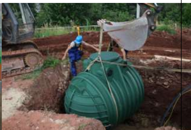
Instalace plastového zásobníku k jímání dešťové vody (zdroj: www.nicoll.cz )
