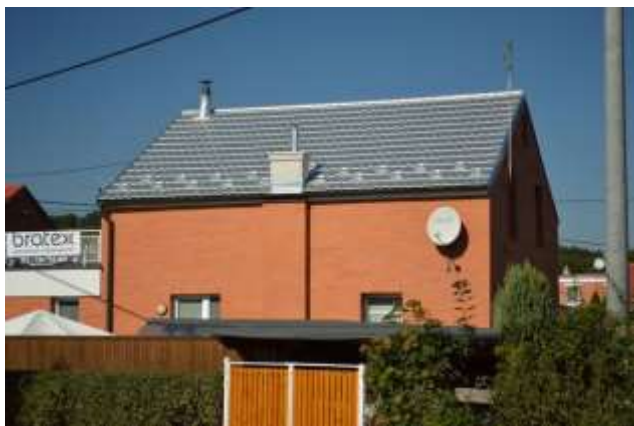
Bílá kovová střecha české produkce (zdroj: www.krytiny-strechy.cz )
