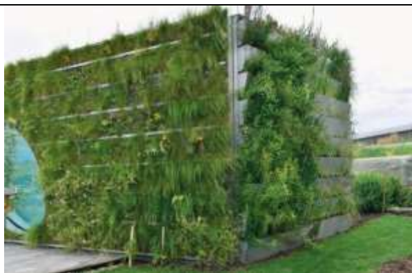
Zelená fasáda budovy vývojového centra společnosti Liko-S ve Slavkově u Brna pokrytá nerezovými kazetami s mokřadními rostlinami v porézním substrátu s bakteriemi pro čištění odpadních vod (zdroj: www.zelenafasada.cz , www.officesnapshots.com )
