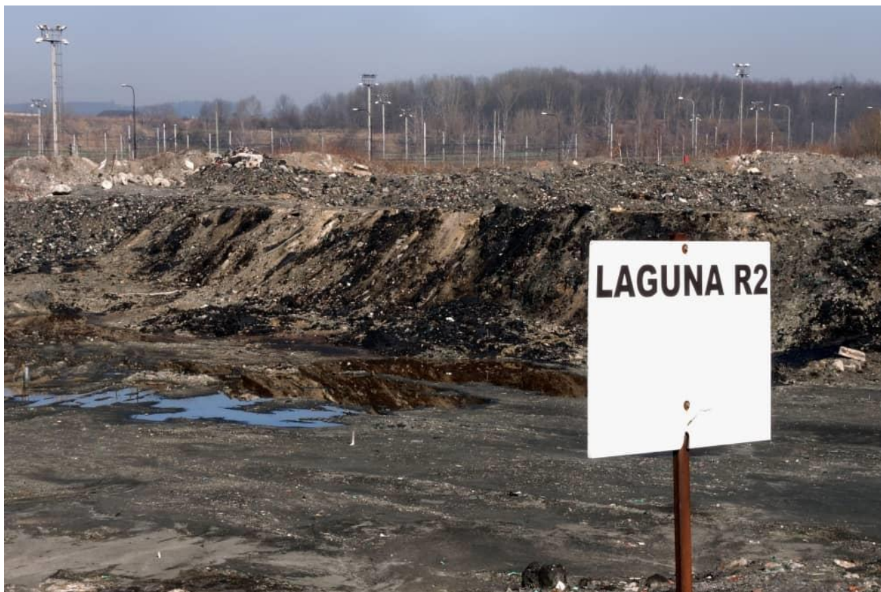
Obrázek 10: Skládku tvoří komplex tří lagun (R1, R2, R3) oddělených hrázemi se zemními valy a jedna laguna (R0) umístěna v zemníku bývalé cihelny
